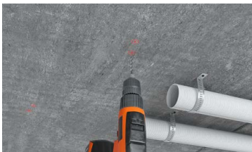
Difuzoriu tvirtinamas prie betono lubų prieš gipso karkaso įrengimą.
