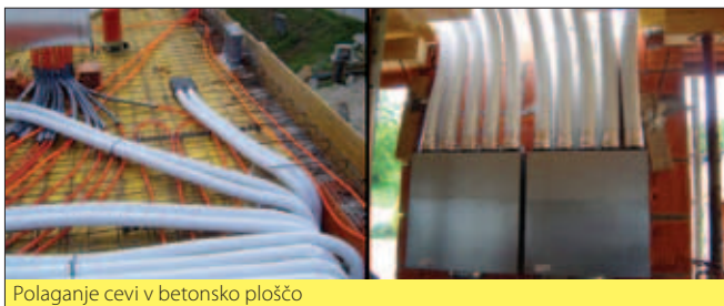
Polaganje cevi v betonsko ploščo
