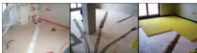
Polaganje cevi na betonsko ploščo, v izolacijo, pod kombinirano ploščo talnega gretja.
